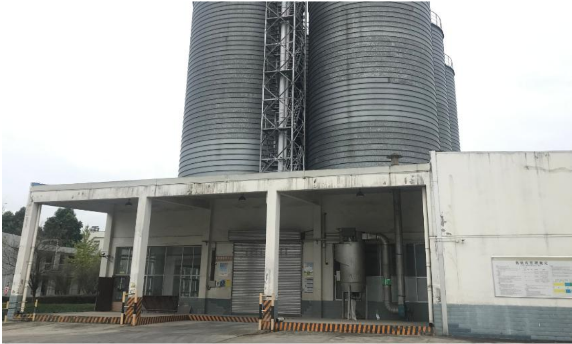
图 4.2-2 项目卸料处脉冲除尘器及配套 10m 排气筒
