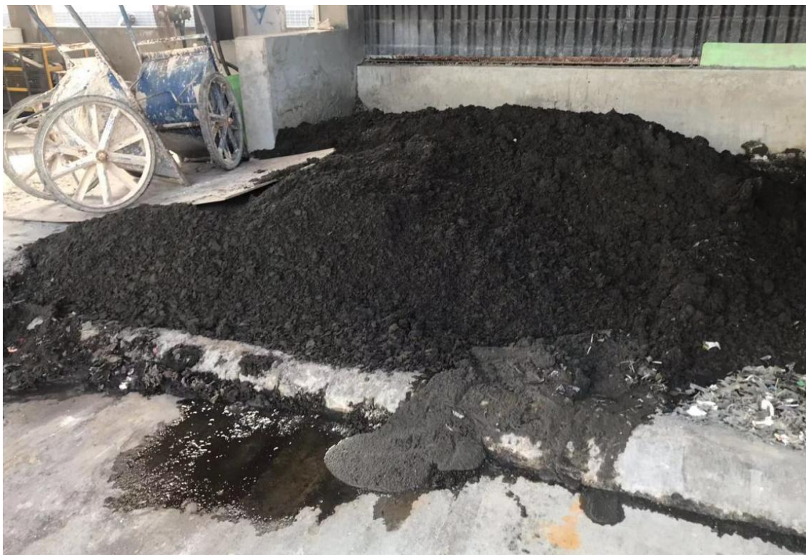
图 5.5-1 项目污泥暂存处未作防渗处理
