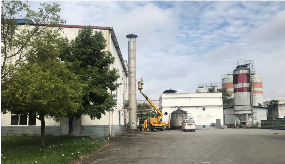
图 4.2-1 项目锅炉房 15m 烟囱
