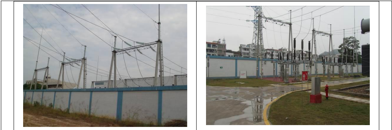
图 4-2 福和变电站现状照片
