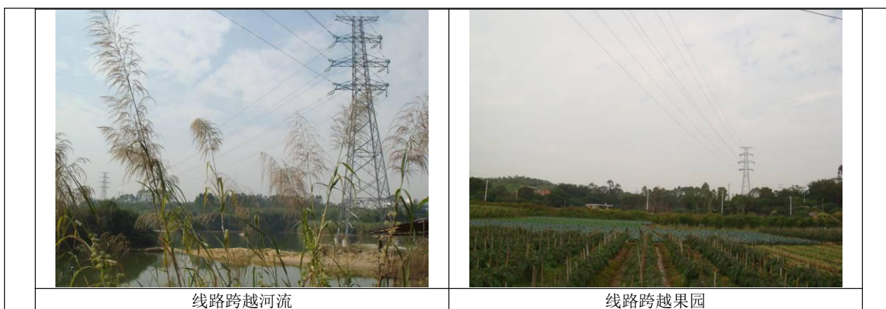
图4-3 输电线路现状照片
