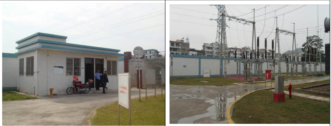
变电站站内绿化
