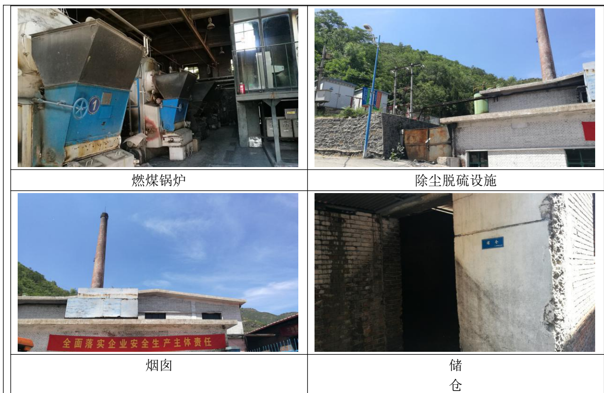
图 4 原大安山 920 锅炉房现状照片
